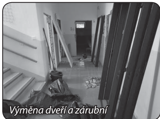
Výměna dveří a zárubní
