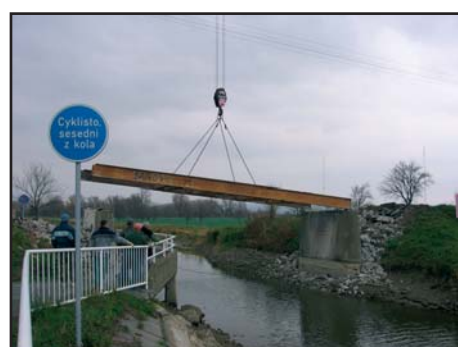
8. listopad 2008 - oprava Chalupského mostu přes Batův kanál, kterou prování Povodí Moravy
